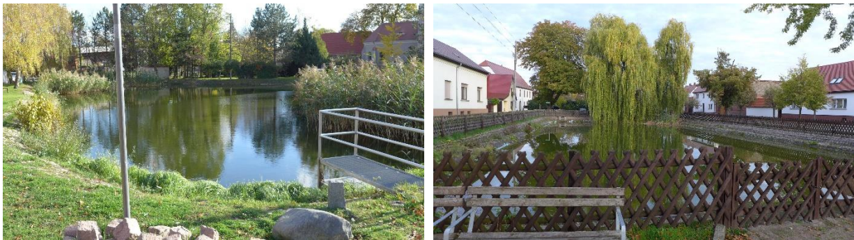
Abbildung 35: Löschwasserteiche in Piethen und Quellendorf (v.l.)
