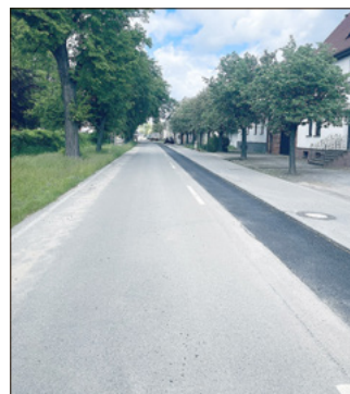
Asphaltierte Hauptstraße mit ausstehender Deckschicht.
